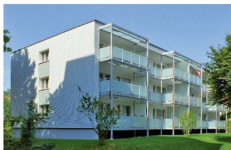
Hinterlüftete Eternitfassaden sind qualitativ hochstehend und beständig – einmal gebaut, bleiben sie Jahrzehnte intakt.
