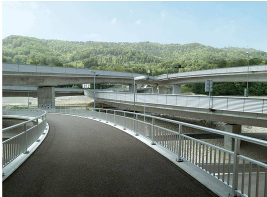
Die Sihlbrücken des Verkehrsdreiecks Zürich Süd bilden das grösste Brückenensemble im Kanton Zürich (Bild: Peter Würmli)
