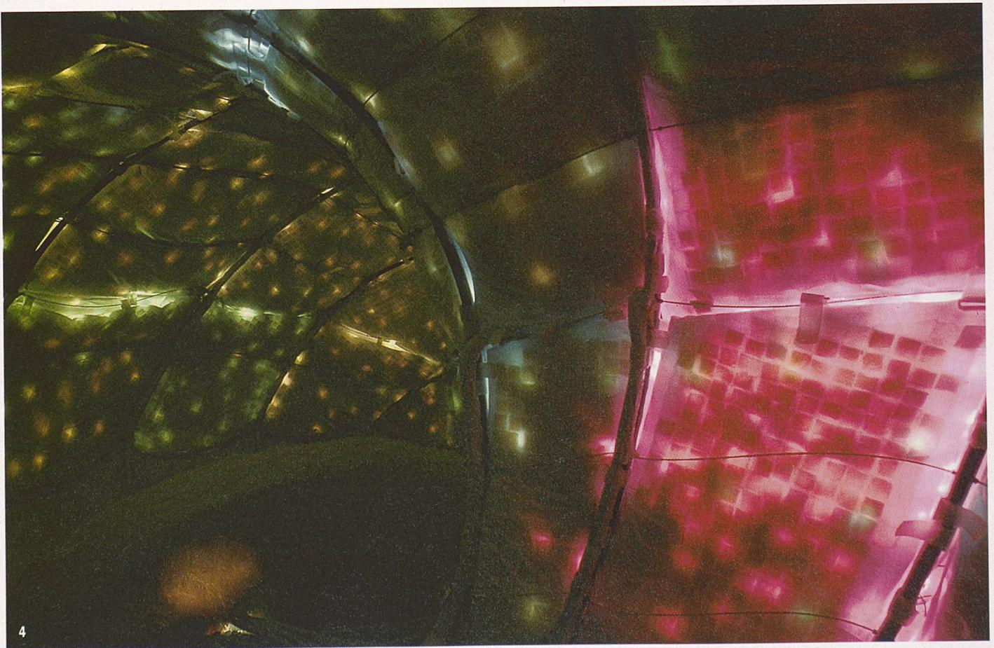
aussen beeindruckend: Die Beleuchtung, durch die mal einzelne Lichtpunkte erkennbar werden, mal ein farbiger Verlauf erzeugt wird, macht die in die Membranen eingenähten Elemente und die «Adern» des insgesamt 8km langen Leitungsnetzes sichtbar. Farbe, Intensität und Verteilung der Beleuchtung ändern sich nach einem elektronisch gesteuerten Schema. Die Falten und die von der Beleuchtung betonte Struktur der Unterkonstruktion beleben die Erscheinung zusätzlich.
