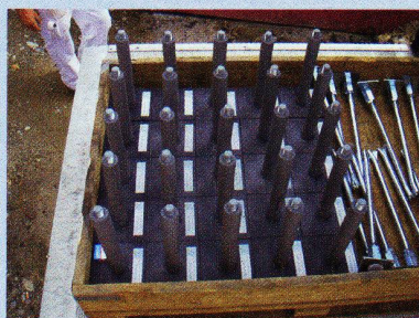
Anlieferung der ZDE-OV-GV-0-30-Elemente
