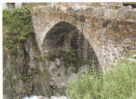
Pont à Wassen, Uri
