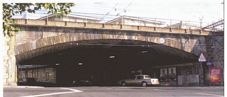
Les viaducs d'Ouchy, Lausanne
