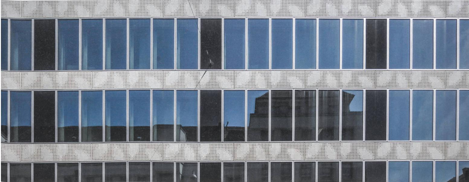
Betonbrüstung individuell: Für die Blätteroptik am Objekt Bleicherweg, Zürich, sorgen Rundungen, die verschieden gross und tief sind. Weitere Ideen und Umsetzungen: betonelementwerk.ch
