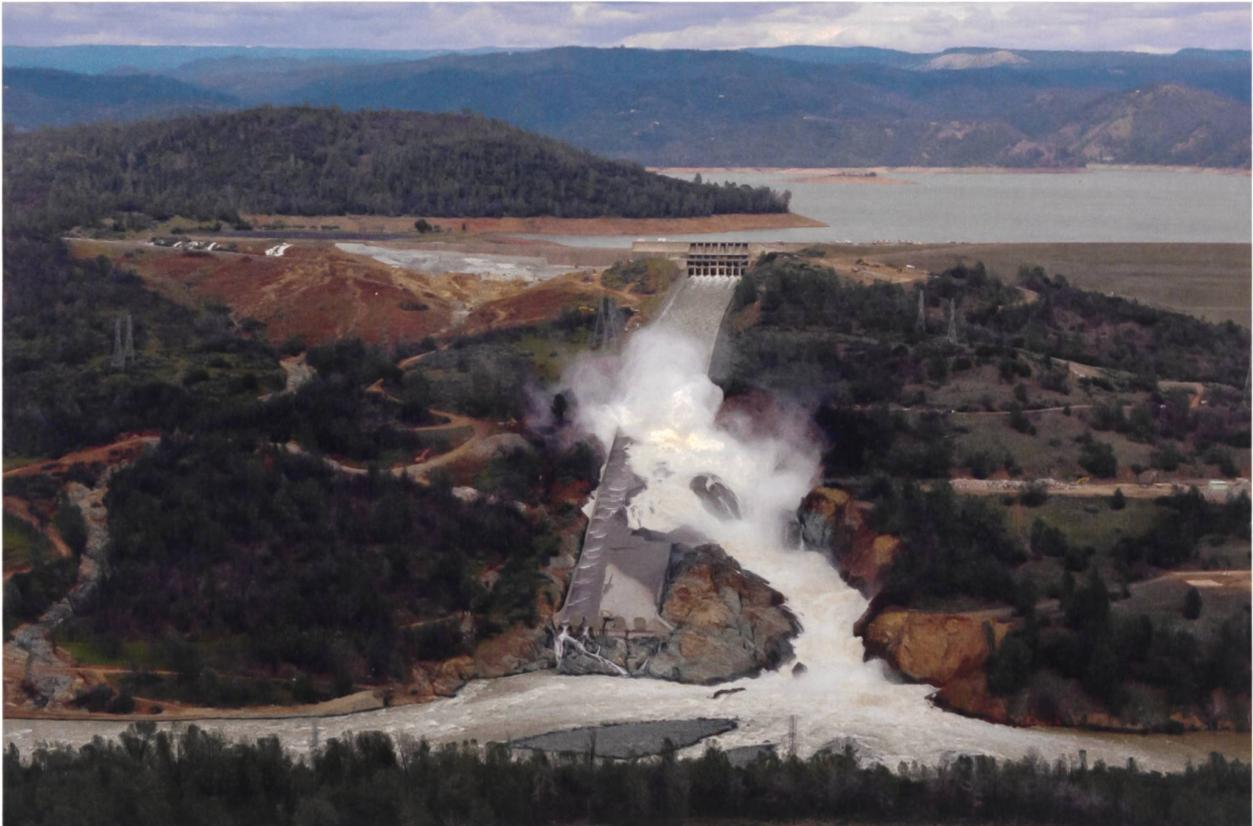
Luftansicht des **Lake Oroville**, 26. Februar 2017: Oben links ist derjenige Teil des Damms erkennbar, der als Überlauf ausgebildet ist, der Hang darunter ist teilweise stark erodiert. In der Bildmitte die **Hochwasser-Notentlastung mit beschädigter Schussrinne**.
