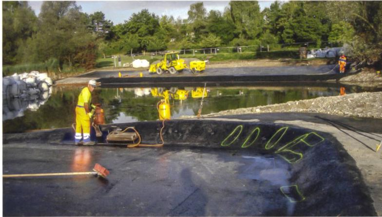
Einbau der Asphaltabdichtung im Uferbereich des Grossweihers.
