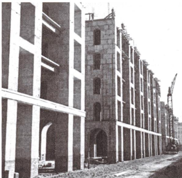
**Baustelle der Wiederaufbauarbeiten:** Deutlich zu erkennen ist die vorgelagerte Raumschicht mit Loggien und erdgeschossigen Arkaden. Dahinter wird der selbsttragend vermauerte Kalkstein mit bewehrtem Beton hinterfüllt.
