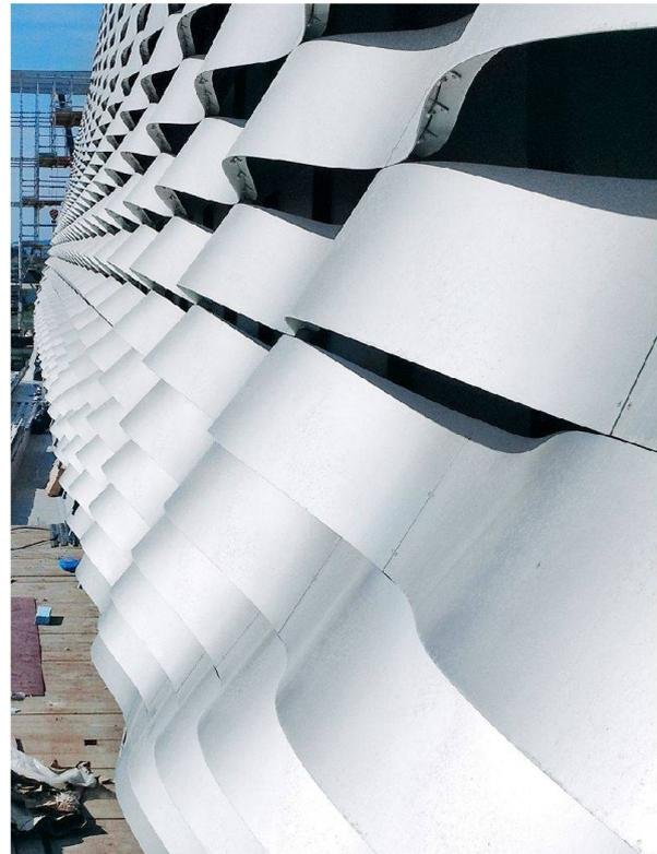
Hinter den locker angeordneten Bändern verbergen sich die 234 voll isolierten Fenster des Baus.
