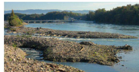
01 Fischtreppe beim Kraftwerk Rheinfelden. (Foto: nc)
