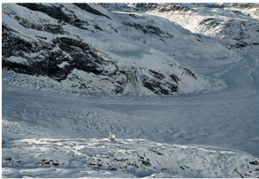
Neue Monte-Rosa-Hütte SAC ETH-Studio Monte Rosa, Departement Architektur; Prof. Andrea Deplazes, Marcel Baumgartner; ETH Zürich Zürich
