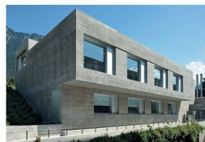
Erweiterung Pädagogische Hochschule GR Pablo Horváth Architekt Chur
