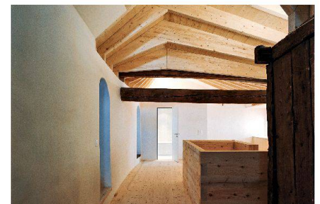
04 Das Falwerk im OG erlaubt ein Maximum an Raumhöhe. Rechts im Bild die Stüvetta, links die beiden Gewölberräume
