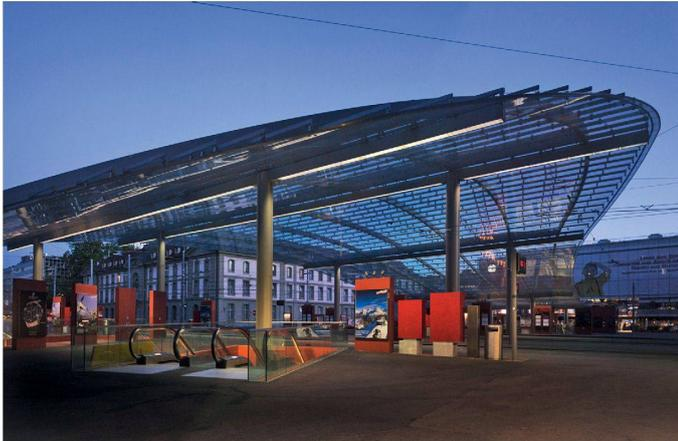
**01 Welle, Bern:** viel diskutierte Stahlkonstruktion aus sechs Kastenträgern auf zwölf eingespannten Stahlstützen und quer verlaufenden, zweifach gekrümmten Sekundärträgern (Bild: Tuchschild / Alexander Gempeler, Bern)
