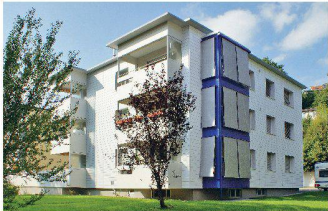
Die Faserzementplatten rücken das sanierte Mehrfamilienhaus zeitgemäss ins Bild, verfälscht dabei aber nicht die ursprüngliche Architektur.
