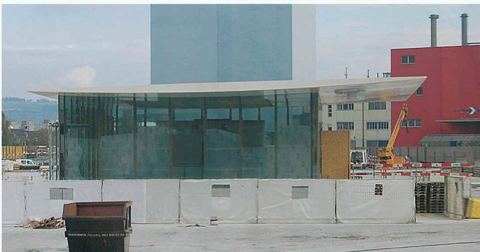
Bild oben: Für das Vordach und die Seitenträger der Passerelle beim «Grand-Hotel» Magglingen werden tragende, transluzente Platten aus Kunststoff eingesetzt (Bild: Swisfiber)
