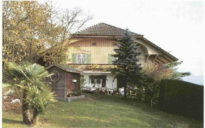
**Als Chalet «verkleideter» Infanteriebunker, 1941, Hilterfingen (BE). Betonbau mit ziegelbedecktem Krüppelwalmdach und gewölbter Dachuntersicht. Aufgemalte Fassade mit Bretterstruktur, Fenstern und Läden. Balkonbrüstung vorgehängt und rebenbewachsen. Unter dem Rücksprung befindet sich der Schartendeckel, der als ein Fenster mit halb geöffnetem Rollladen erscheint (Bild: Christian Schwager)**
