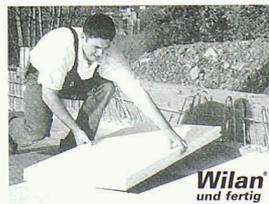
Isolationselemente **einseitig** belegt mit äusserst widerstandsfähigen Fertigdeckschichten aus Kunststoffen, Faserzement oder Holzwerkstoffplatten Für das direkte Einlegen und einbetonieren in Deckenschalen oder für nachträgliche Montagen.
