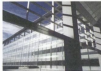
sade des ETH-Erweiterungsbaus auf dem Höngerberg eingesetzt wird. Dank Vorfertigung können auf der Baustelle bis zu 30 m<sup>2</sup> grosse Elemente rationell montiert werden. Die neusten Technologien machen bei Rahmen und Glas eine Verbesserung der Wärmedämmung um 40 Prozent möglich. Für die thermische Sonnenergie-nutzung steht ein neuer Flachdachkollektor mit selbstentleerendem Absorber und integrierter Sammelleitung zur Verfügung.
