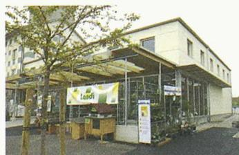
Die Landi in Gipf-Oberfrick AG ist die erste Landi-Verkaufszentrale mit dem Minergie-Label. Die Fassadenverkleidung besteht aus einer hinterlüfteten Faserzement-Platte. Das extensiv begrünte Flachdach wurde als Warmdach ausgebildet und
