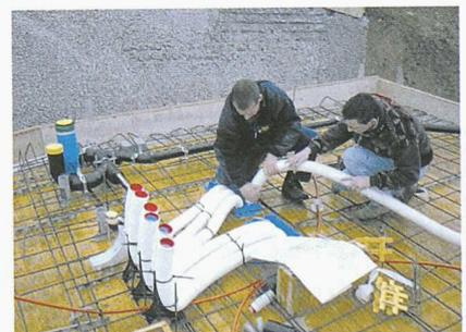
Einfach verlegbares, flexibles Lüftungssystem comfofresh mit wenigen Komponenten
