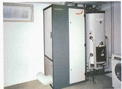
Betriebsbereite, wartungsarme Kompakteinheit comfoair für das MINERGIE Einfamilienhaus mit Sole-/Wasser-Wärmepumpe mit Kühlfunktion
