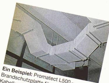
Ein Beispiel: Promat L500 – Brandschutzplatte für Lüftungs- und Kabelkanäle.
