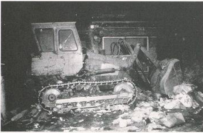
Bild 1. Hartbetonbelag unter Dauerbelastung. Hartstoffe auf der Basis von Stahl bewirken eine erstaunliche Widerstandsfähigkeit gegenüber Stoss-, Schlag- und Abrasionsbelastung
