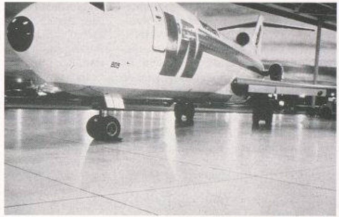
Bild 3. Hartbetonbelag in lichtreflektierendem Weiss
