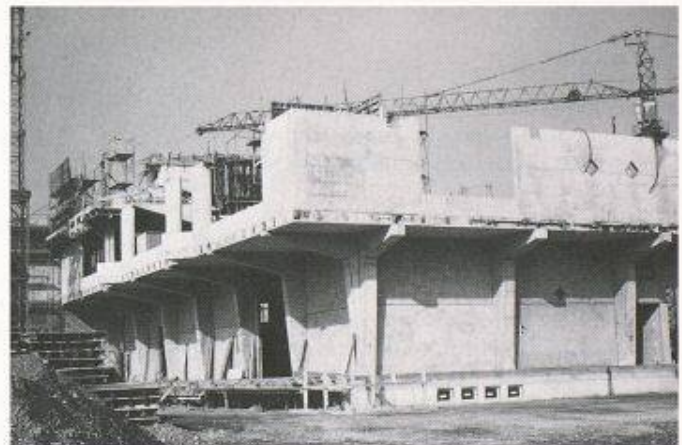
Bild 14. Vorgespannte Winkelstützen zur Unterstützung der Auskragung
