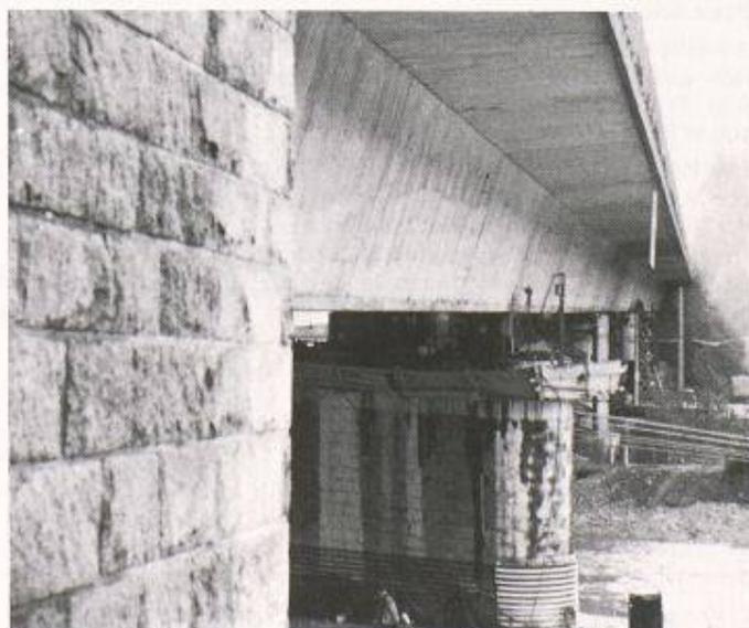
Bilder 1 und 2. Spannbetonüberbauten der Innbrücken in Kufstein über dem um 1,28 m abgesunkenen Flusspfeiler: vor (Bild 1) und nach dem Anheben in die ursprüngliche Lage (Bild 2).
