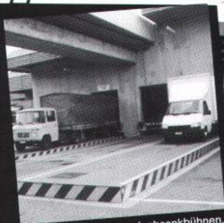
z.B. Lastwagenhub- und -absenkbühnen, auf Strassenniveau überfahrbar.
