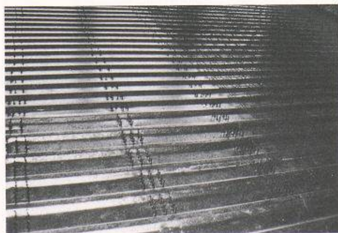
Bild 2. Trapezbleche und Verbundschrauben von oben gesehen
