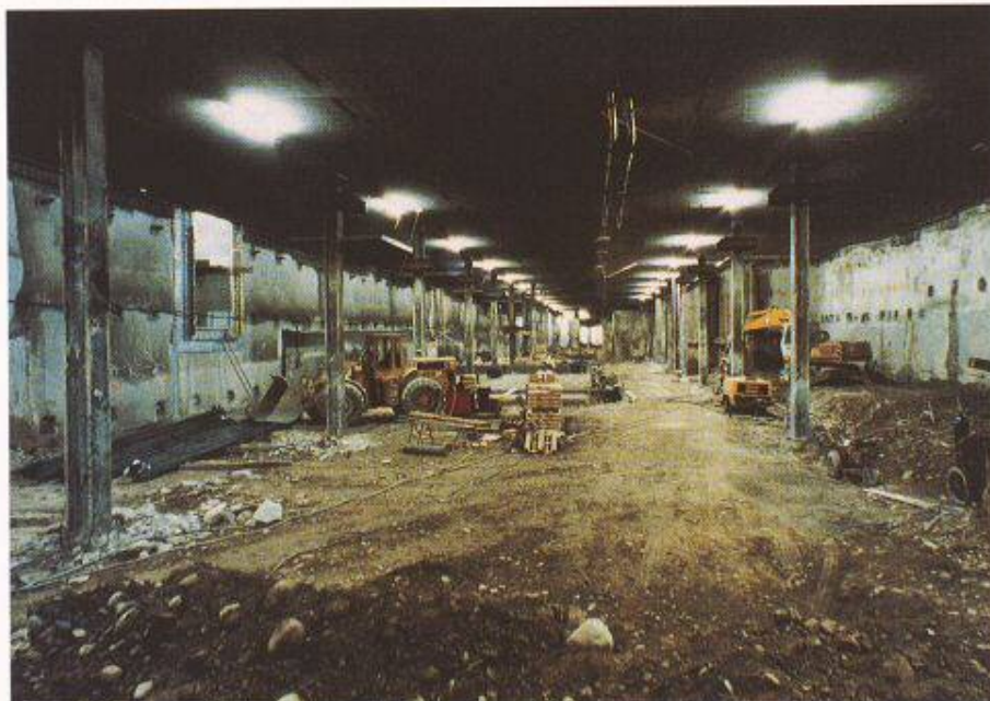
Bild 4. Passage Löwenstrasse, Bauzustand Ende 1987
