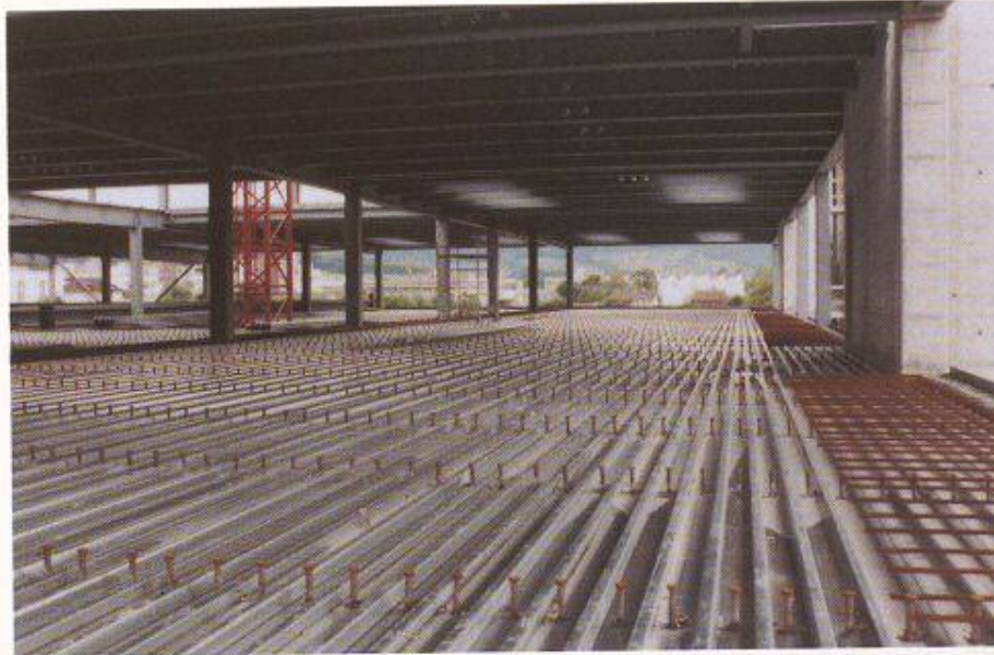
Bild 4. Zwischengeschossboden einer Haupthalle vor dem Betonieren
