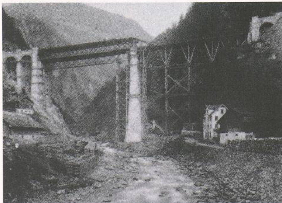
Bild 6. Bau der Kerstelenbachbrücke 1880
