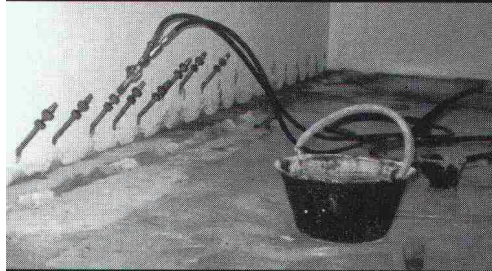
Elastische Abdichtungs-Injektion-Rascoflex in einer Zivilschutzanlage.
