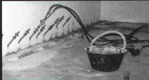
Elastische Abdichtungs-Injektion-Rascoflex in einer Zivilschutzanlage.
