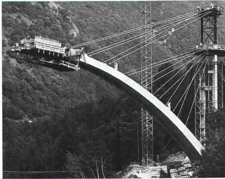
Bau der Ponte Soi-Brücke, Lukmanier-Route.
