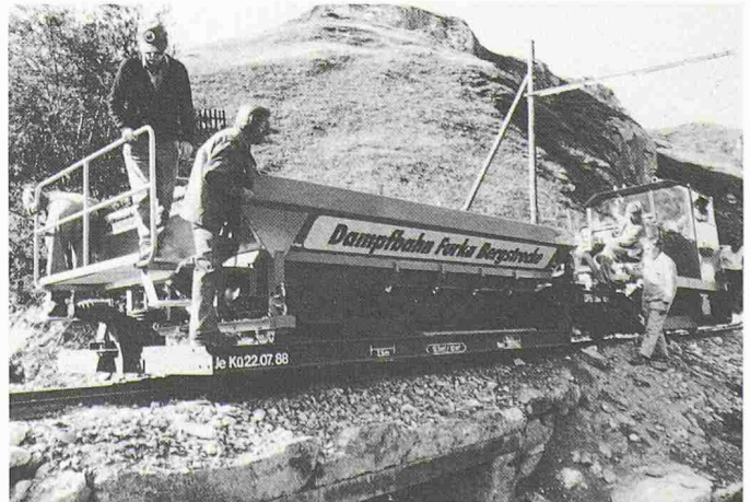
Mit dem Eigenbau-Tiefadewagen und Wechselbehälter auf erfolgreicher Probefahrt
