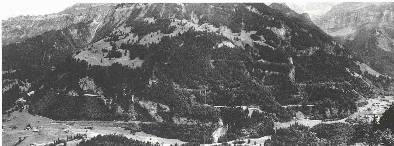
Bild 2. Die fertiggestellte Doppelspur auf der Nordrampe kurz vor der Betriebsübergabe 1988
