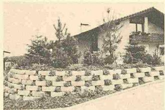
Die Steine werden trocken verlegt, in engem oder weitem Abstand. Die durchdachte Formgebung ermöglicht einen individuellen Aufbau der Mauer mit verschiedenen Neigungen, Ecken, Kurven. Aufgrund des leichten Gewichtes kann der Secondo-Stein auch vom Hobbygärtner mühelos versetzt werden. Das mit Boden ausgebildete und nach hinten offene Element erlaubt das Verwurzeln der Bepflanzung mit der Hinterfüllung und bildet somit eine gute Vegetationsgrundlage.
