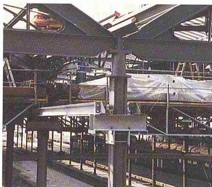
Bild 4. Nördliche Hallenverlängerung mit Schutz- und Arbeitsbühne
