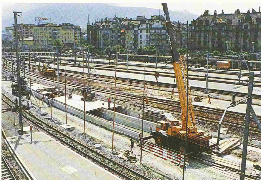
Bild 5. Bau Perron 5. Versetzen der Hohlplatten mit Autokran. Im Bereich des Fahrleitungsmastes sind die verstärkten Platten noch nicht versetzt. Im Vordergrund der fertiggestellte Perron 6. Die ebenfalls sichtbare provisorische Verlängerung ist bis 1990 erforderlich, da wegen der Provisorien beim Bau des Aufnahmegebäudes eine Verkürzung am Stirnperron nötig wurde. Ganz im Hintergrund Perron 1, dazwischen situiert die noch zu bauenden Anlagen
