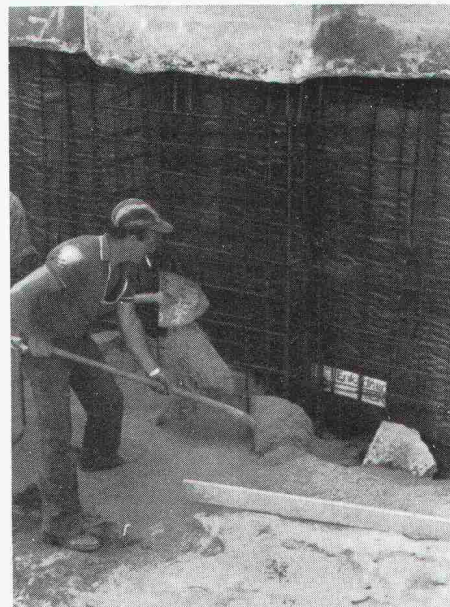
Rückwärtige Unterfangungsetappe mit bereits versetzter Enkadrain-CK-Matte als verlorene Schalung
