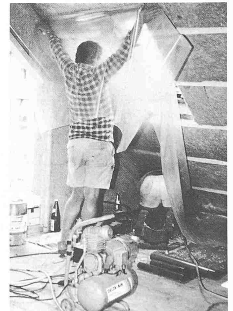
Bild 8. Der Einbau grossflächiger Luftdichtigkeitsschicht, zusätzliche Wärmedämmschicht an Sparrenunterseite
