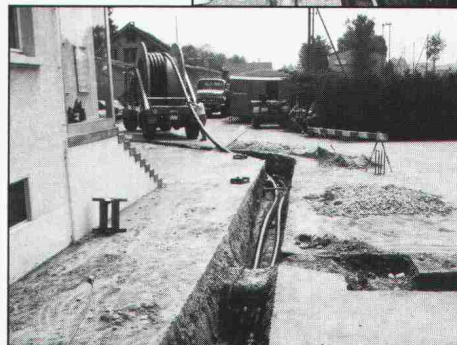
FLEXWELL-Leitungen von der Rolle in den Graben
