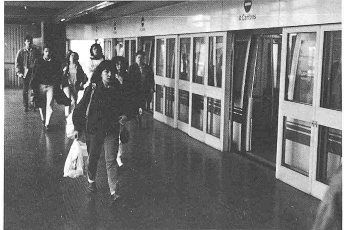
Bild 5. Der Bahnsteig ist vollständig vom Lichtraumprofil der Métro abgetrennt. Zugang zu den Fahrzeugen besteht nur an vorgegebenen Stellen, wobei sich die Bahnsteig- und Fahrzeugtüren gleichzeitig öffnen und schliessen - im Prinzip wie bei einem Lift. (Bild: Verfasser)
