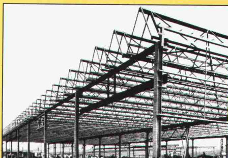
Metalstruktur eines Fabrikgebäudes mit Mini-Sheddach
