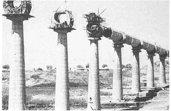
Bild 19. Aquädukt in Indien: Vorfabrizierte Betonelemente im Freivorbau mit Klebefugen
