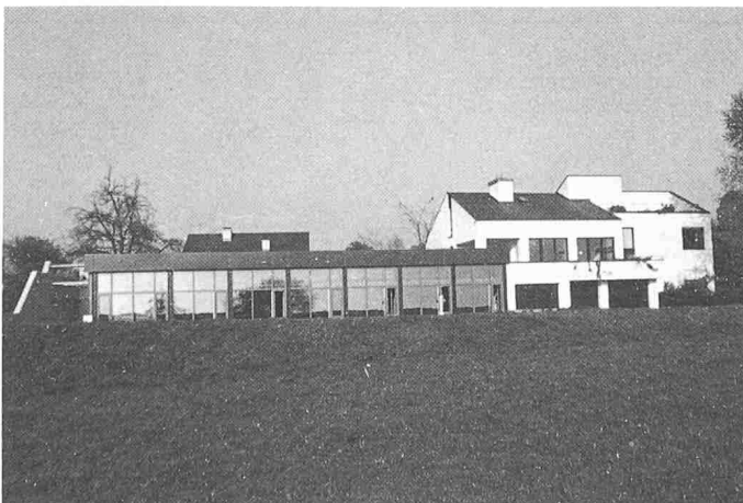
Bild 1. Gesamtansicht von Süden; links erdbedeckter Bürobau, rechts Wohnhaus
