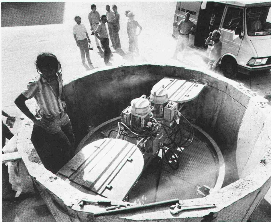
Die Demontage-Einrichtung wird für den Einsatz im Hochkamin zusammengebaut. Von oben nach unten: Anhängetraverse für Betonelemente mit Arbeitskorb; Kaminsägemaschine mit Arbeitsplattform; höhenverfahrbare Vorbereitungsstufe.
