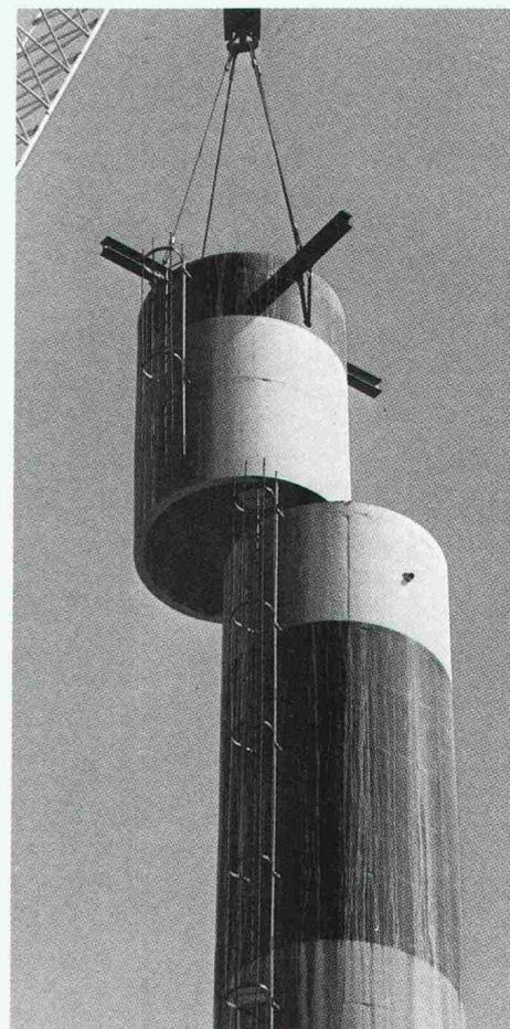
*Einer der bis zu 4,60 m hohen Eisenbeton-Kaminteile (Durchmesser 2,98 bis 4,88 m) wird mit dem Pneukran abgehoben.*
