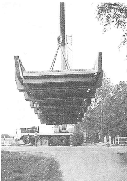
Bilder 4 und 5. Einbau der Aalachbrücke am 2.9.1986 mittels Hydraulikkran
