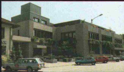
Neubau Postgebäude PTT Lyss LYSS/BE
