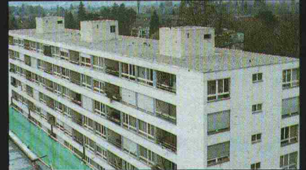
Sanierung MF-Häuser Kasthoferstrasse 40-44 und 46-50 BERN
