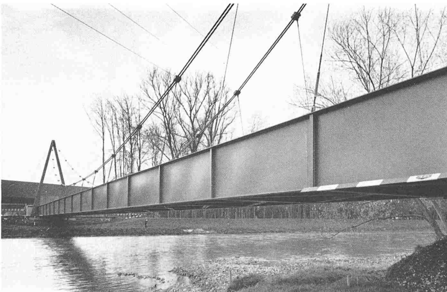
Bild 5. Die Hängebrücke nach Abschluss der Montagearbeiten
