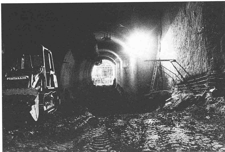
Bild 3. Unterfahrung Publicitasgebäude: Aushub im Schutz der auf Pfählen fundierten Bodenplatte; Blick Richtung Schacht Limmat, mit dem ausbetonierten Gefrierabschnitt der Axe 200
