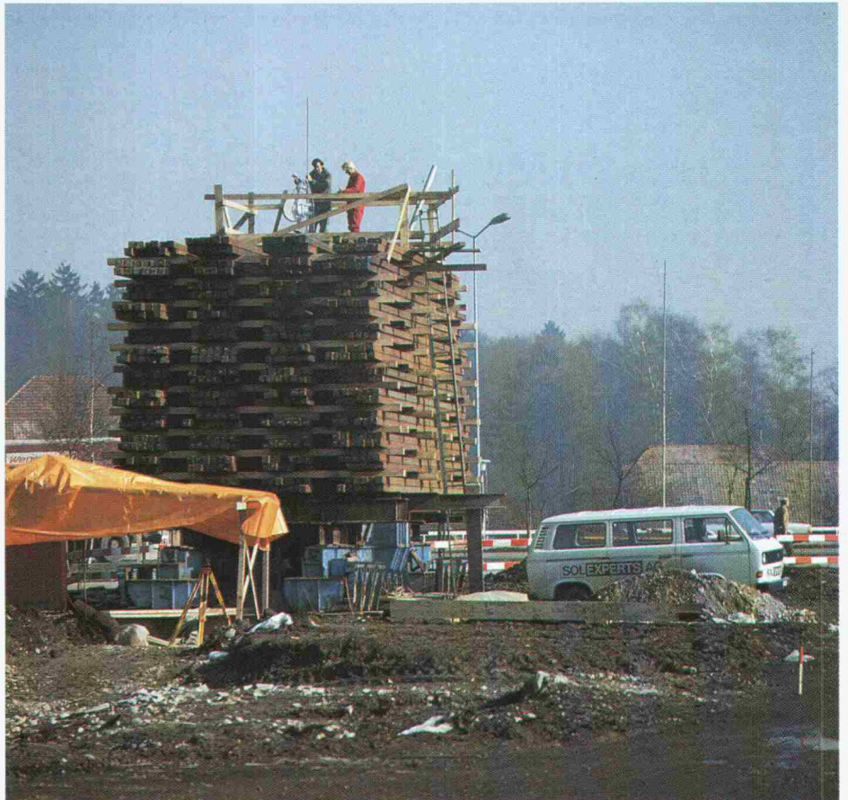
Pfahlbelastungsversuch Viadukt Neugut
